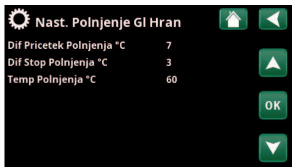
Meni: »Instalater/Nastavitve/Solarni paneli/Polnjenje glavnega hranilnika«.
