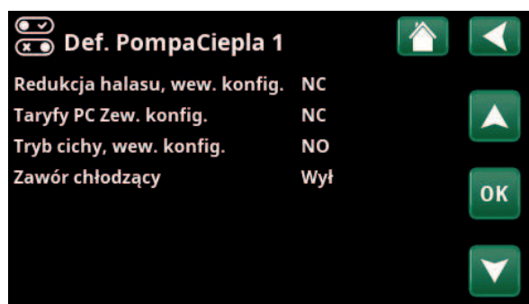
Menu: „Instalator\Definiuj\Pompa ciepła\Pompa ciepła 1”.
